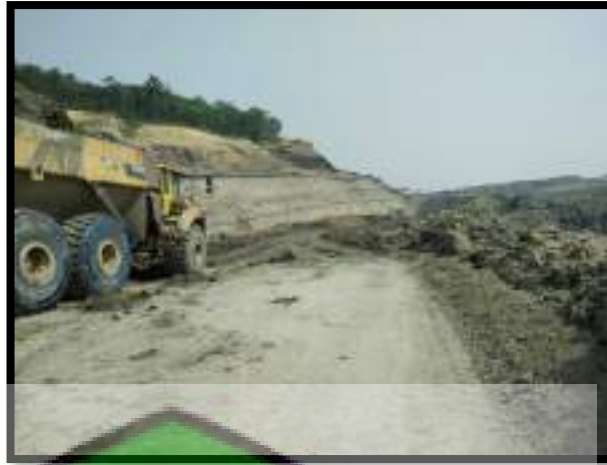
Gambar 4.10 Tidak Ada Separator Jalan
